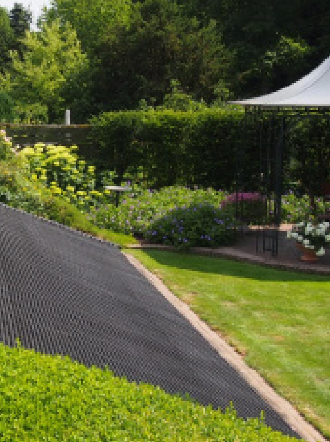
Die solare Poolheizung kann praktisch überall installiert werden. Ob auf einer Rasenfläche oder dem Hausdach. Bei schrägen Dächern werden die Profile oben in Halterungen eingehängt. Da der Wind zwischen den Rohren hindurchstreichen kann, entsteht kein Segeleffekt. Ein Festkleben der Anlage ist nicht nötig.
