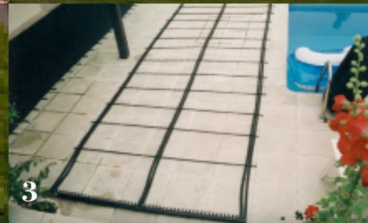
zum Kollektor. Ein Vorteil der patentierten „Solar-Rapid“-Rohre ist ihr hoher Wirkungsgrad, wie Kai Maurer von der Firma Roos erläutert: „Geht man von einem Idealwert von 1000 Watt pro Quadratmeter bei Sonneneinstrahlung aus, erzielen unsere Solar-Absorber einen Wirkungsgrad von über 91 Prozent.“ Selbst bei diffusem Licht und bewölktem Himmel sei der Wirkungsgrad immer noch bei 60 bis 70 Prozent, so Maurer. Schon im Frühjahr ist die Heizwirkung enorm. Kai Maurer nennt ein Beispiel:
