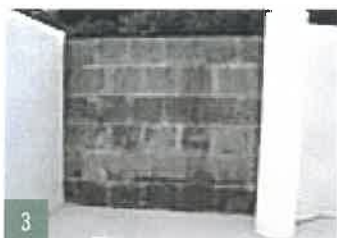
3 Die Boden und die Wände werden dann mit Isolier- und Polsterschaum belegt.
