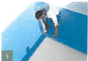
5 Die Bahnen der Schwimmbadfolie werden über Boden und Wände ausgelegt.
