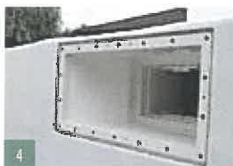
4 Im nächsten Schritt werden die Einbauteile entsprechend ausgeschnitten .
