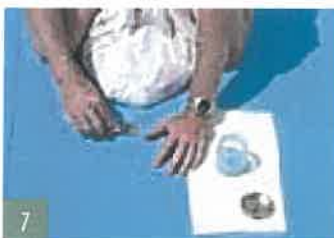
7 Überlappungen werden mit Aktivierungsmittel und Flüssigfolie doppelt dicht verschweißt.
