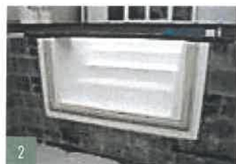
2 ... werden die Einbauteile und optional eine Badetreppe miteingebaut.
